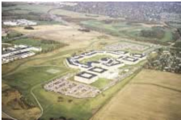
Ikke-stationsnært byggeri til kontorformål i Lautrupparken.
