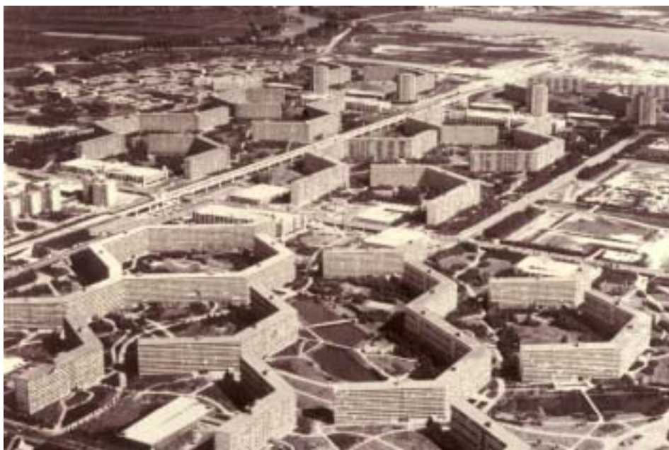
Bijlmermeer er Amsterdams socialt mest belastede boligområde. Bebyggelsen består af 12.000 lejligheder i næsten ens 10-etagers boligblokke opført 1968-75 i det sydøstlige Amsterdam.
