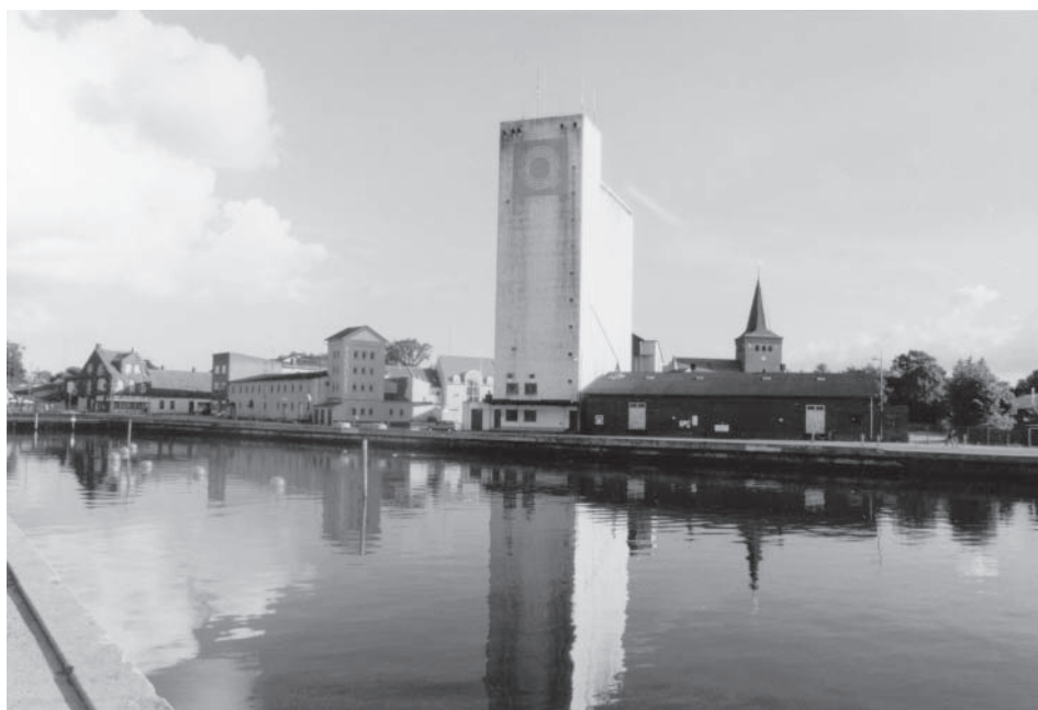
Qvades silo i Sakskøbing havn ombygges til boliger med finansiering af forsøgsmidler fra by- og boligministeriet.
