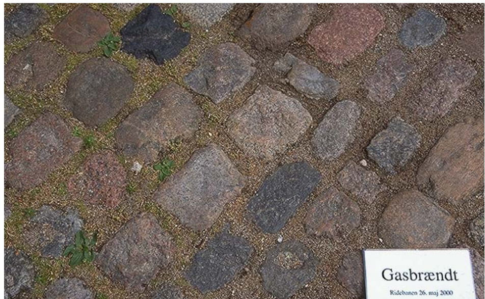
Figur 19. Højre halvdel af belægningen er flammebehandlet fire gange senest 19 dage før dette foto er taget på Ridebaneanlægget d. 26. maj.
