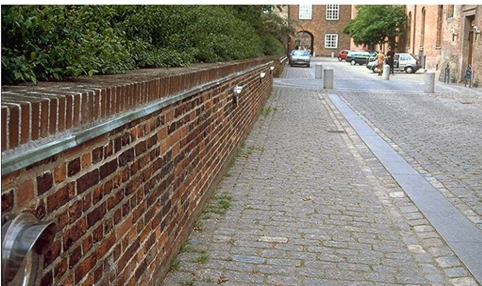
Figur 14. Efter at der ikke har været udført børstebehandling i 1½ mdr. er der en utilfredsstillende ukrudtsmængde. Foto fra d. 8. august.
