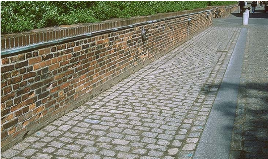
Figur 13. Belægningen var efter udførelse af 3 børstebehandlinger tilfredsstillende rent. Foto fra d. 28 maj.
