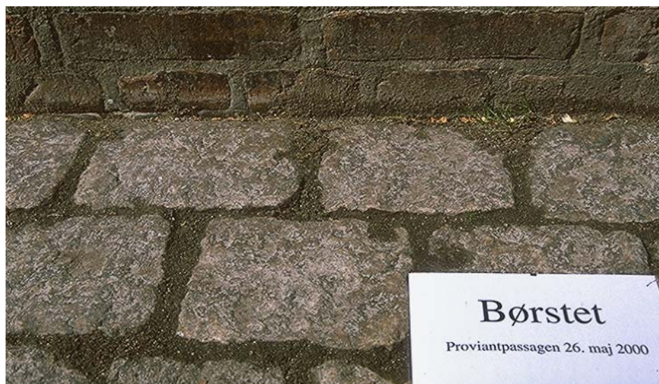
Figur 16. Selvom der kan udføres børstebehandlinger, der også fjerner ukrudet i den inderste langsgående fuger uden at ramme muren, vil det som kontinuert driftmetode være for risikabelt, da der kan ske beskadigelse af murværket. Foto fra Proviantpassagen d. 26. maj.
