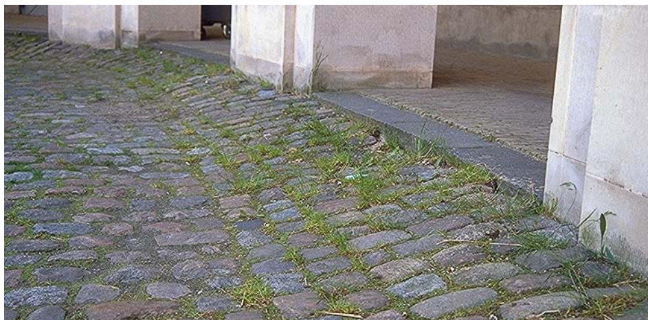
Figur 2. På ridebaneanlægget er der fra belægningsfladen og op mod arkaderne et skrånende belægningsareal, der er stærkt tilgroet med ukrudt. Foto fra d. 26. maj.
